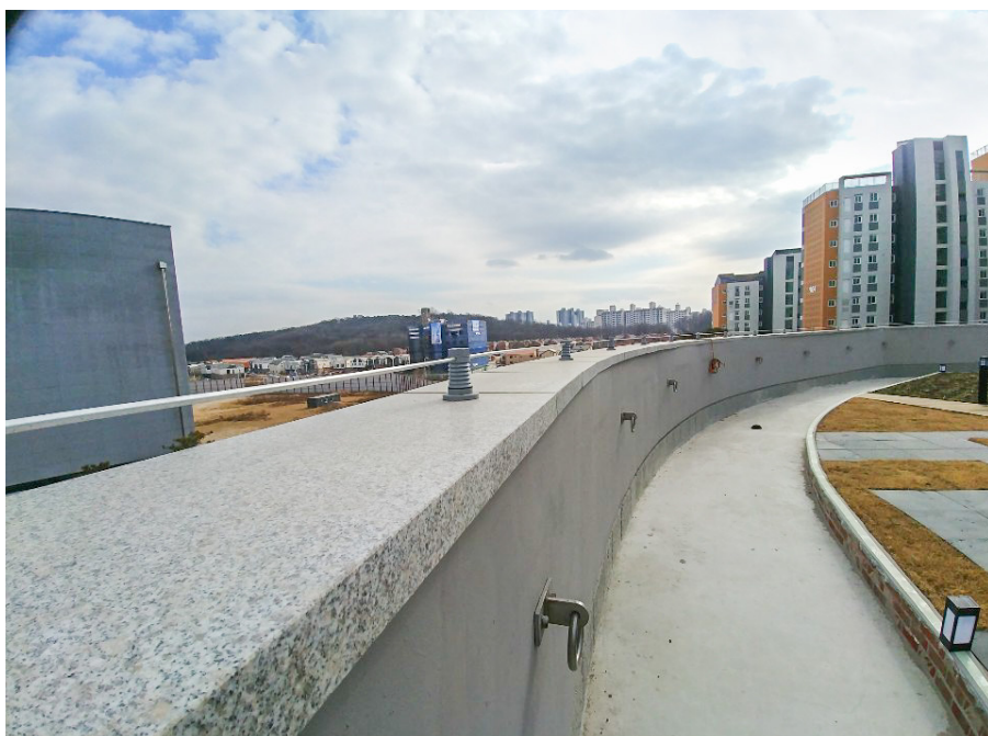
알루미늄 수평도체 설치
