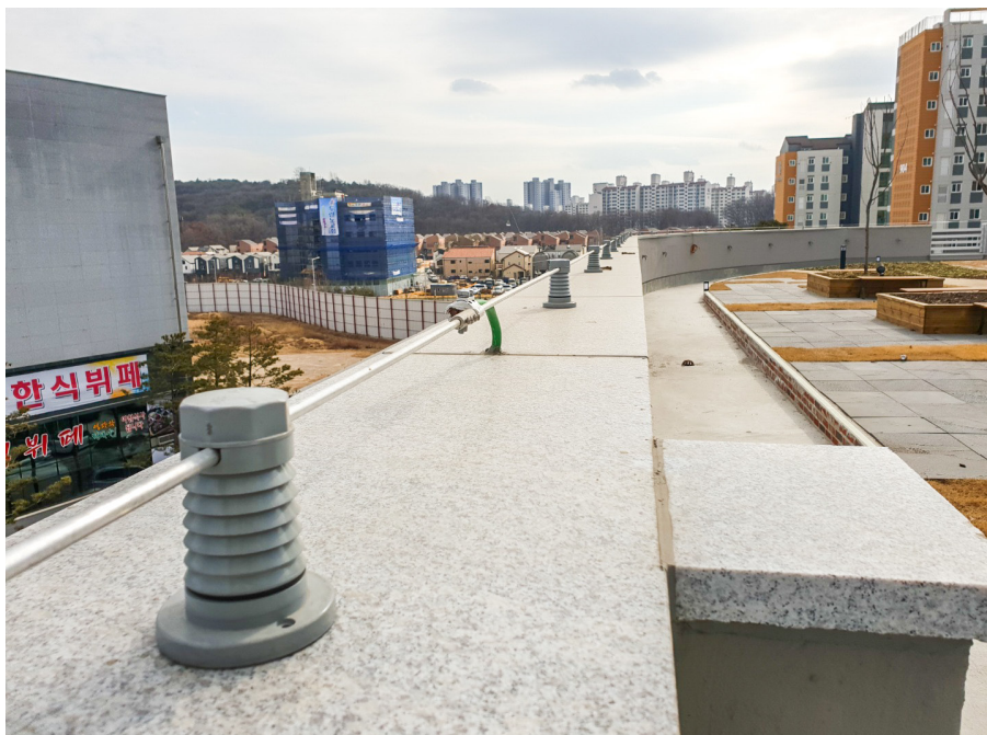
알루미늄 수평도체 설치
