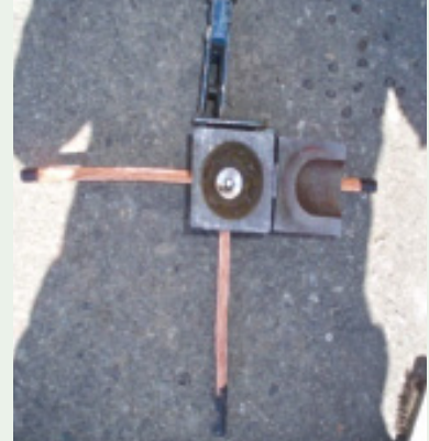
03 Mold 안에 Metal Disk로 구멍을 막는다.
