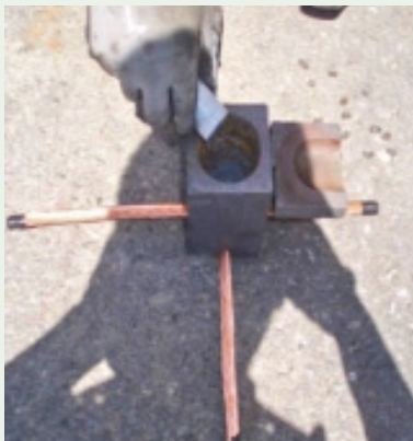
04 Mold 안에 Weld Metal을 잘 부어 넣는다.
