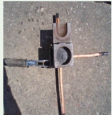
06 Mold와 뚜껑이 만나는 장자리에 Starting Metal을 잘 부어 놓는다.
