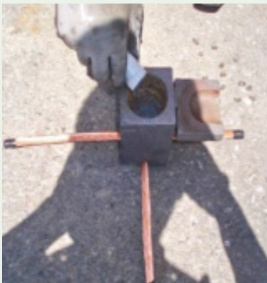
04 Mold 안에 Weld Metal을 잘 부어 넣는다.
