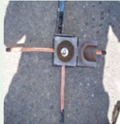
03 Mold 안에 Metal Disk로 구멍을 막는다.
