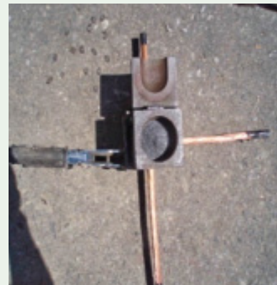
06 Mold와 뚜껑이 만나는 장자리에 Starting Metal을 잘 부어 넣는다.
